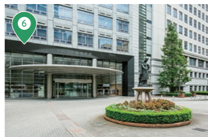
6 メインエントランス Main entrance
